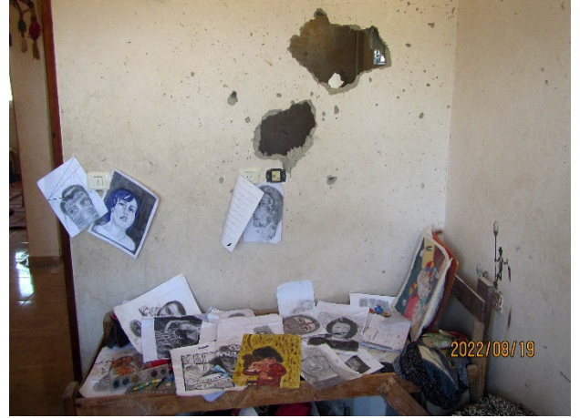
Dunyana El Amur'un yatak odasındaki çizimi, duvarda delik açan ve Dunyana'nın 5 Ağustos 2022'de ölümüne yol açan mermi nedeniyle hasar görmüş © Uluslararası Af Örgütü
